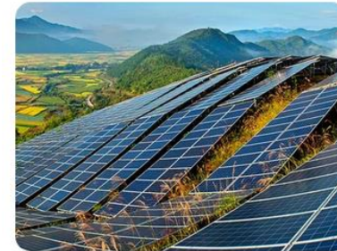
Elementy konstrukcji wsporczej
